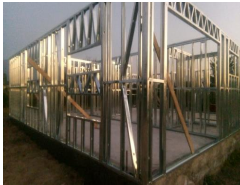
Montaje en Obra
